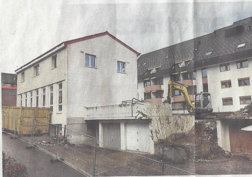
Im Januar wurde das ehemalige Gebäude der Heilsarmee abgerissen.
